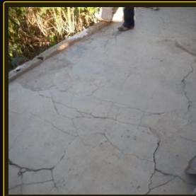
Piso trincado
